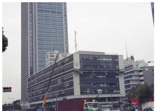
阪神・淡路大震災における神戸市役所庁舎の被害
