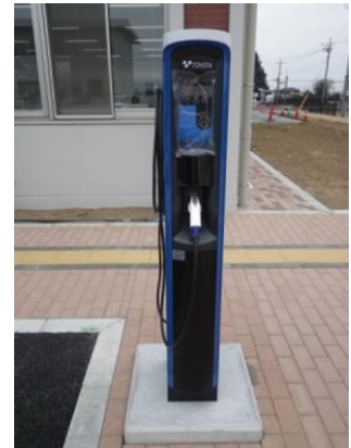
充電ステーション
