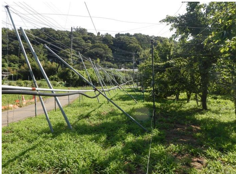
道路際の単管撤去箇所
