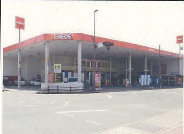
屋内給油取扱所 (二宮町内現有数0施設)
