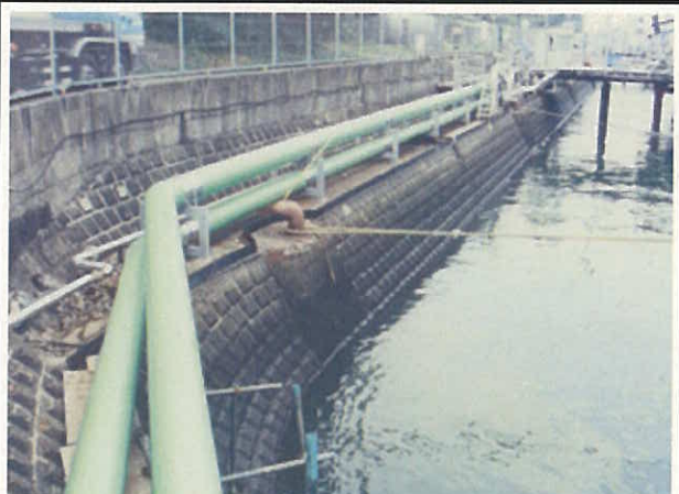
移送取扱所 (二宮町内現有数0施設)
