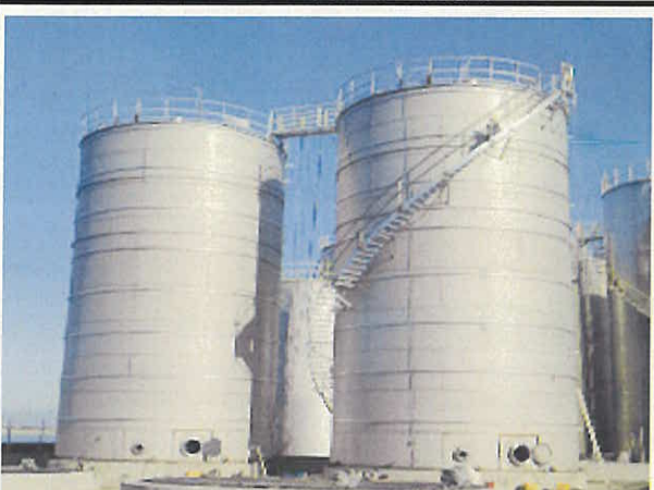
※ 特定屋外タンク貯蔵所(屋外にある貯蔵タンクで最大数量1,000kℓ以上の危険物を貯蔵する施設) 準特定屋外タンク貯蔵所(屋外にある貯蔵タンクで最大数量500kℓ以上1,000kℓ未満の危険物を貯蔵する施設)
