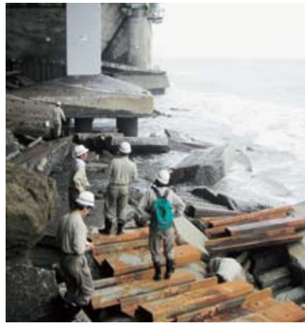
台風で消えた袖が浦海岸と破壊された西湘バイパスの基礎
