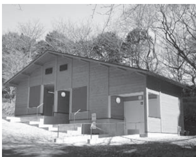
昨年度中に整備された公園内のトイレ
