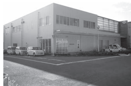
昨年8月から稼働している給食センター
