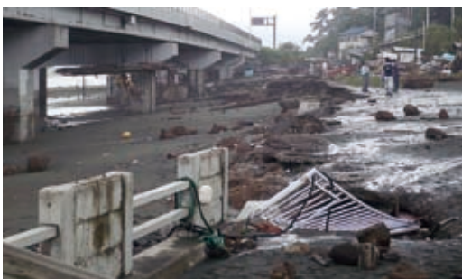
平成19年台風時の被害
