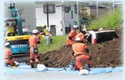
消防力と民間の力(建設協力会)の連携を確認！
