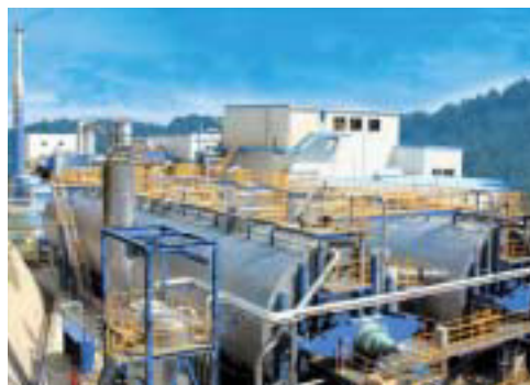
日本で数少ない稼働している厨芥類資源化施設（民間） 厨芥（生ごみ）などの有機性廃棄物からメタンガスなどを取り出す施設です。
