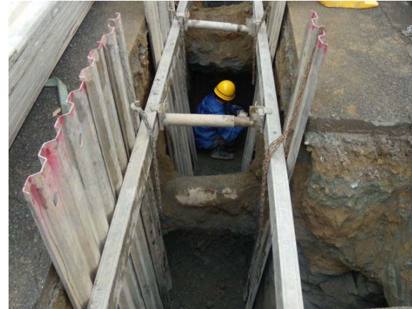
開削工法による工事
