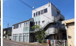
山西防災コミュニティセンター
