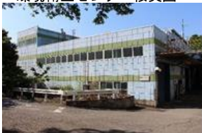
環境衛生センター桜美園
