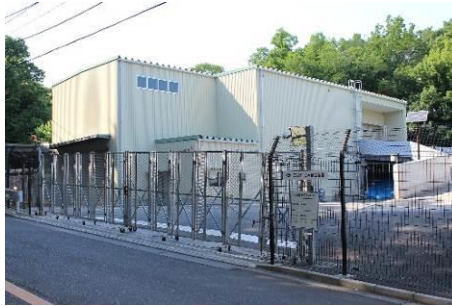
図 43 ごみ積替え施設の外観
