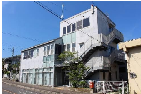
山西防災コミュニティセンター
