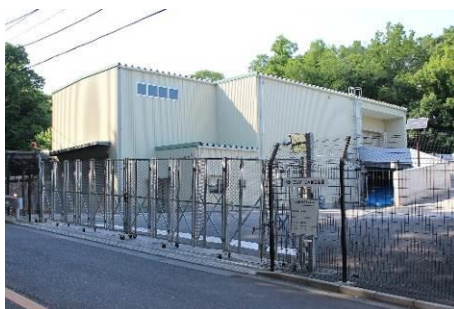
図 72 ごみ積替え施設の外観
