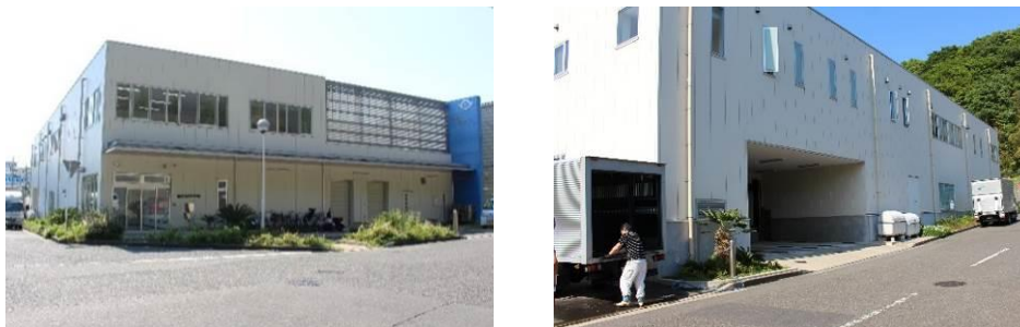
図 54 学校給食センターの外観
