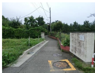
⑤東側隣地の状況(体育館方面)
