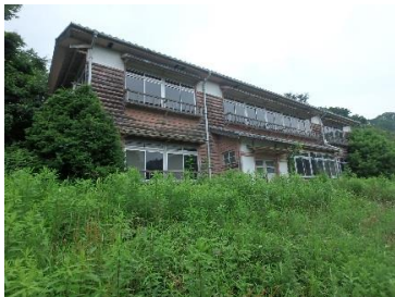
④B地区内には大小8棟の木造建築が点在している。
