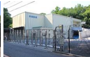
ごみ積替施設
