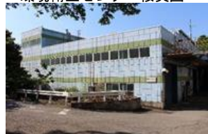
環境衛生センター桜美園
