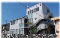
山西防災コミュニティセンター
