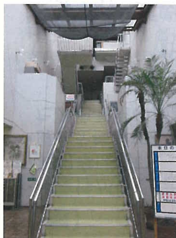
施設中央の階段。 上階に行くには階段を登らなければならない
