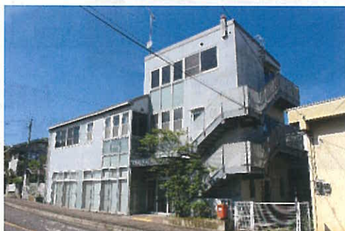
山西防災コミュニティセンター
