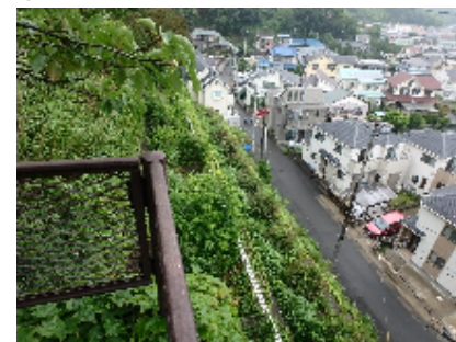
⑨北側擁壁(庁舎側から見下げ)
