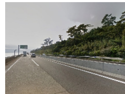
③西湘バイパスからの見上げ(Google)
