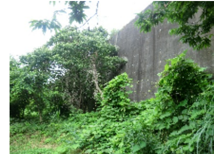
③B地区からA地区側・小田原厚木道路の擁壁を臨む。
