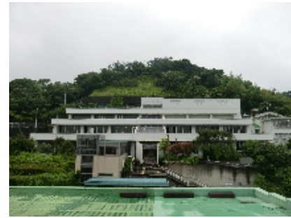
⑤町民センター外観
