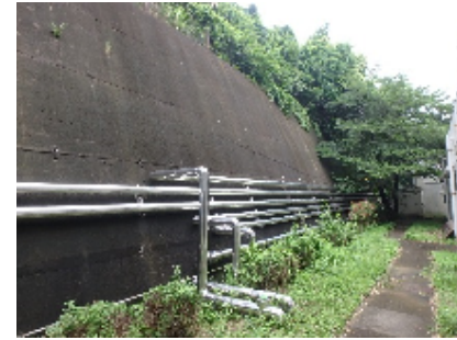
⑫町民センター背面擁壁
