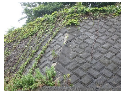
⑧北側擁壁(部分)
