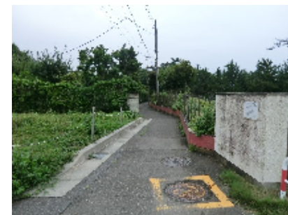
⑥東側隣地の状況(体育館方面)
