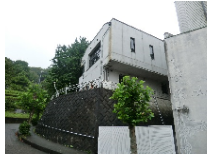
⑩町役場南側擁壁
