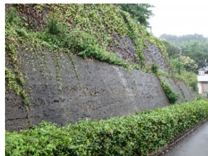
⑦北側擁壁
