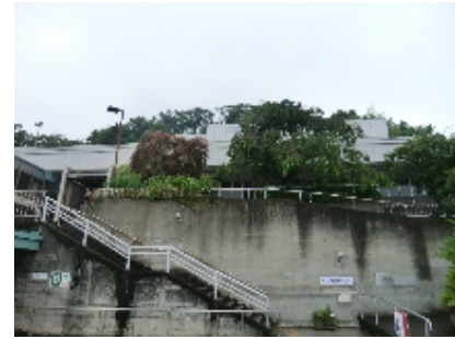
⑪町民センター正面擁壁
