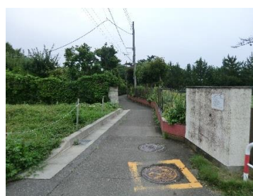
⑤東側隣地の状況(体育館方面)
