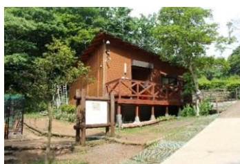
吾妻山公園管理棟
