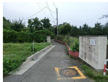
⑥東側隣地の状況(体育館方面)
