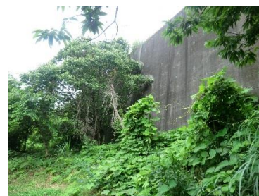
③B地区からA地区側・小田原厚木道路の擁壁を臨む。
