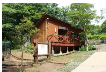
吾妻山公園管理棟
