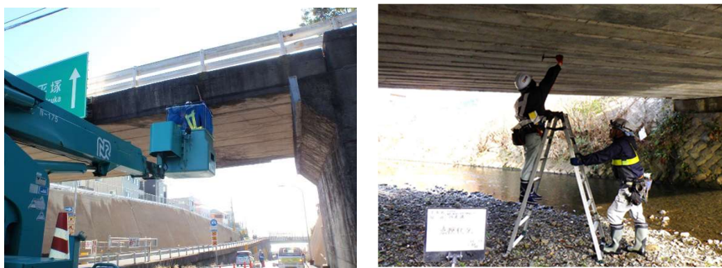
写真6-1 橋りょう点検状況
