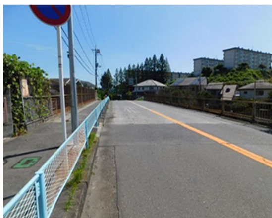
中里第二架道橋
