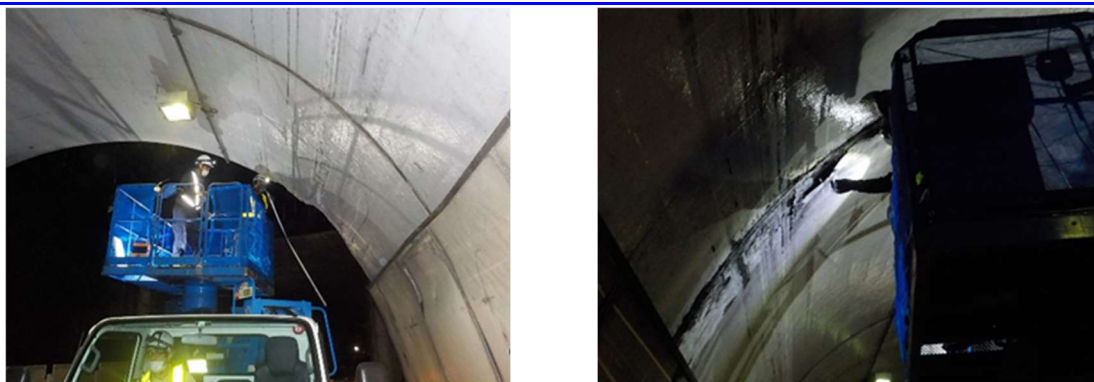
写真6-1 道路トンネル点検状況
