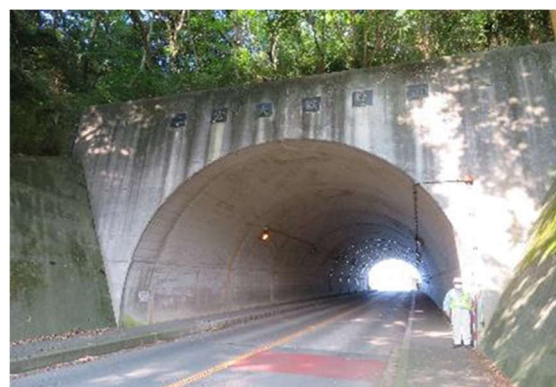
二宮大磯隧道
