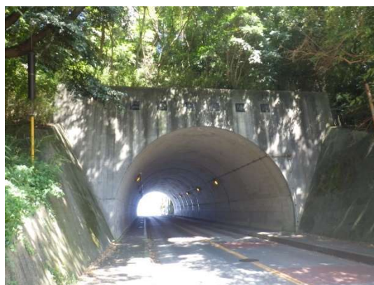
二宮大磯隧道
