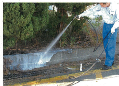
専門業者による液剤の高圧散布
