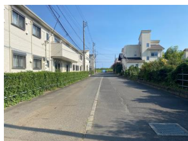
《国道1号からの進上路》
