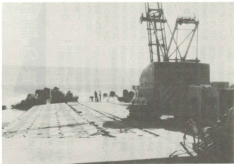
基礎工事はすでに完了しています
