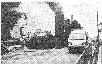
着々と進む歩道工事
