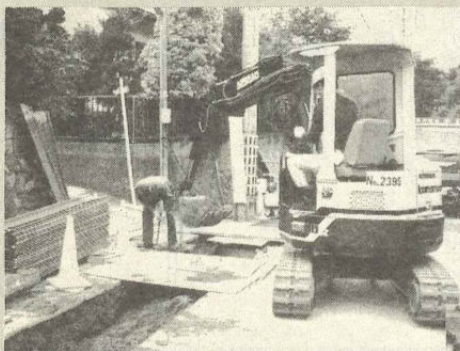
公共下水道工事始まる (茶屋地区の一部)
