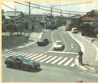
拡幅され歩道も整備された町道(茶屋地区)
