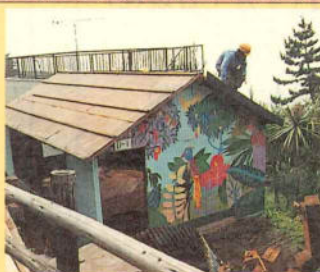
袖が浦バンガロー最後の棟、解体
