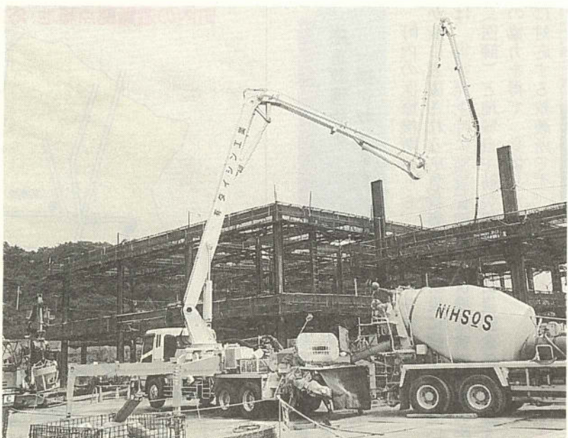
新しい図書館の鉄骨組み(北側から撮影)
