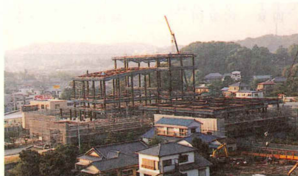
施設の骨組みが立ち上がり 建設工事は順調に進んでいます
