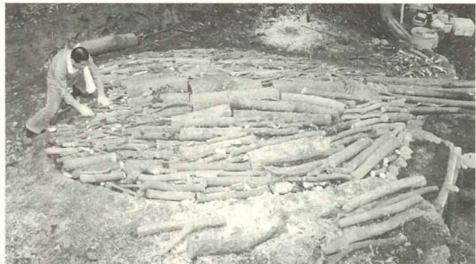
木材をぎっしり並べてこの上に土の壁をつくります（5月19日撮影）
