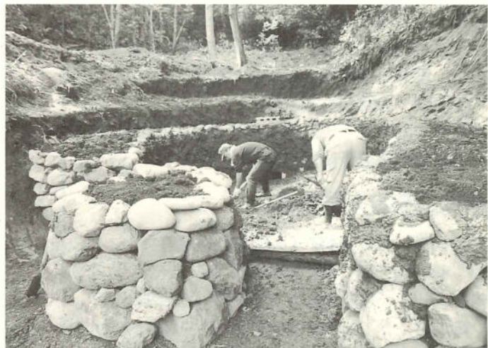
石と泥だけで窯の壁面をつくります（5月11日撮影）
