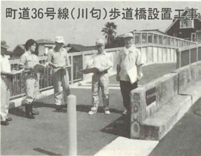
監査委員による現地監査
