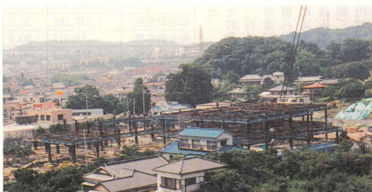
基礎工から鉄骨部分が立ち上った11年7月ごろ
