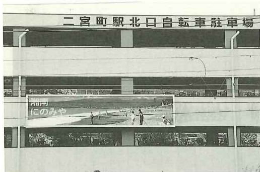
北口自転車駐車場の壁面に湘南にのみやをイメージアップする看板ができました。夜になると照明が入り浮かび上がります。
