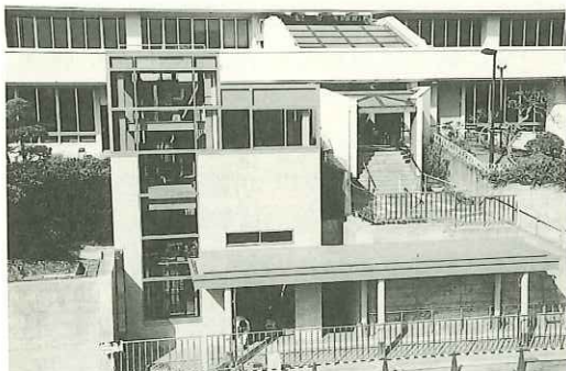
社会福祉センターの入口にエレベーターが取り付けられました。
