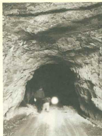
車一台がやっと通れる広さだった 釜野トンネル
