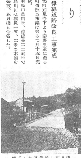
完成した谷津線と花月橋
