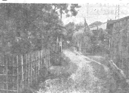
側溝工事完成
