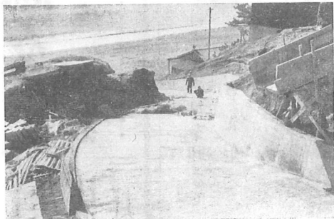
(完成を急ぐ船揚場道路)
