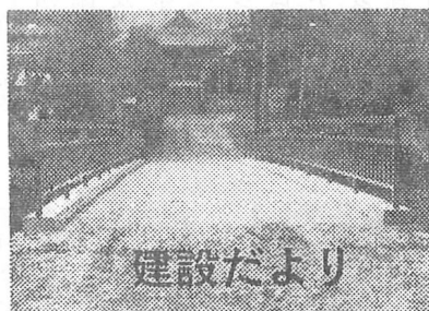
完成した大応寺橋
