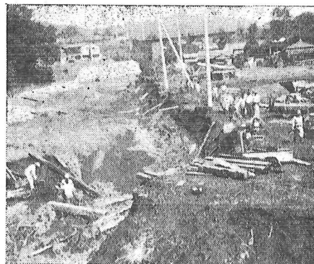
台風四号で決壊した押切川
