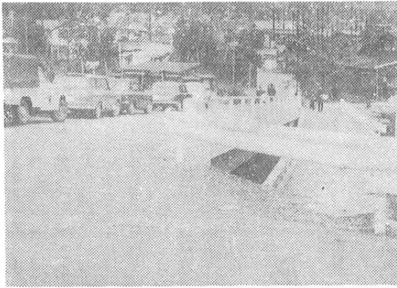
↑県道付け替道路と結ぶ新原田橋
