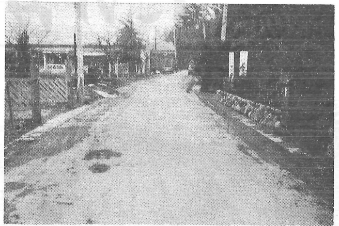
舗装になった開拓道路（大磯虫窪へ通ずる道路）
