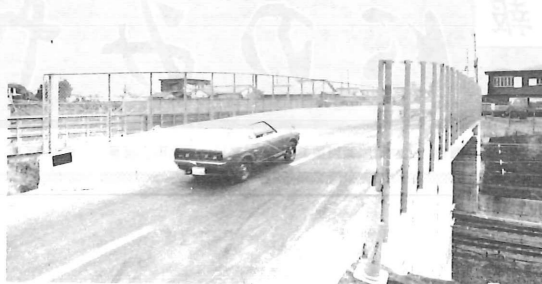
11月30日 川勾陸橋完成
