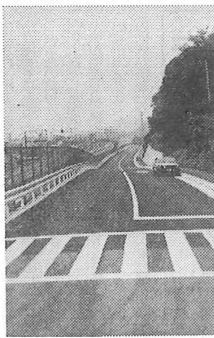
開通した内原釜野線
