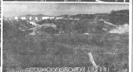
二宮高校の敷地造成工事が進む(12月5日)
