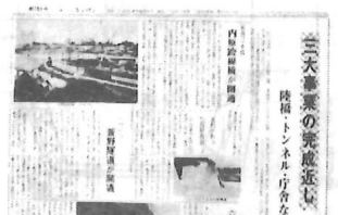
陸橋、トンネル、庁舎の完成近し S53.5……185号
