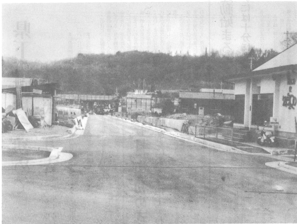
歩道のついた安全な道路が完成します
