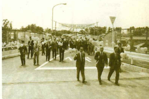
駅北口と山西方面を結ぶ原跨線橋完成
