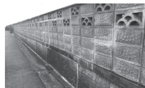
古いブロック塀の撤去補助19件は、すべて通学路上
