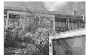
基本設計に進む新庁舎整備 現庁舎は老朽化が進む
